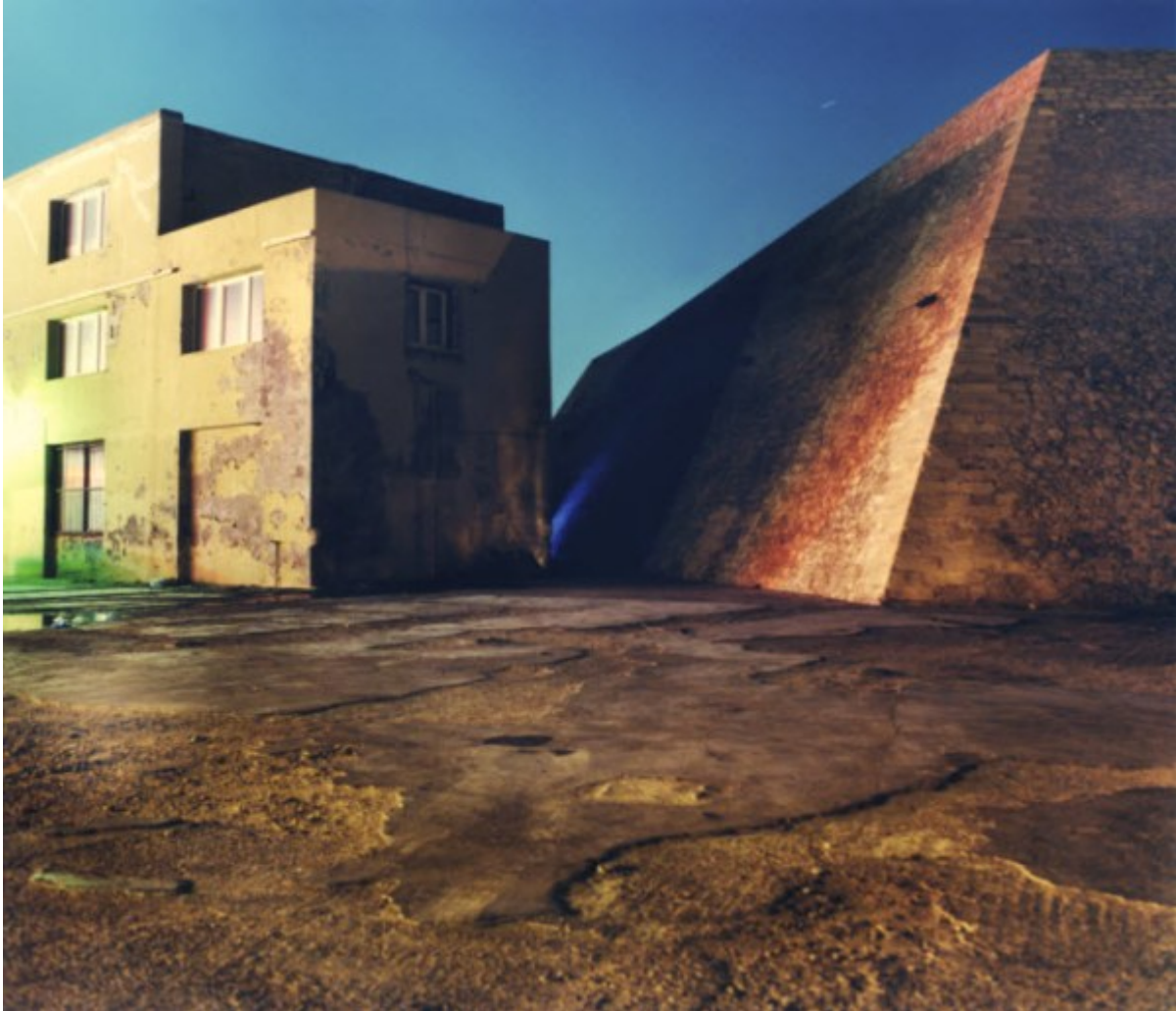
HERAKLION Προμαχώνας Αγίου Ανδρέα, 2002
