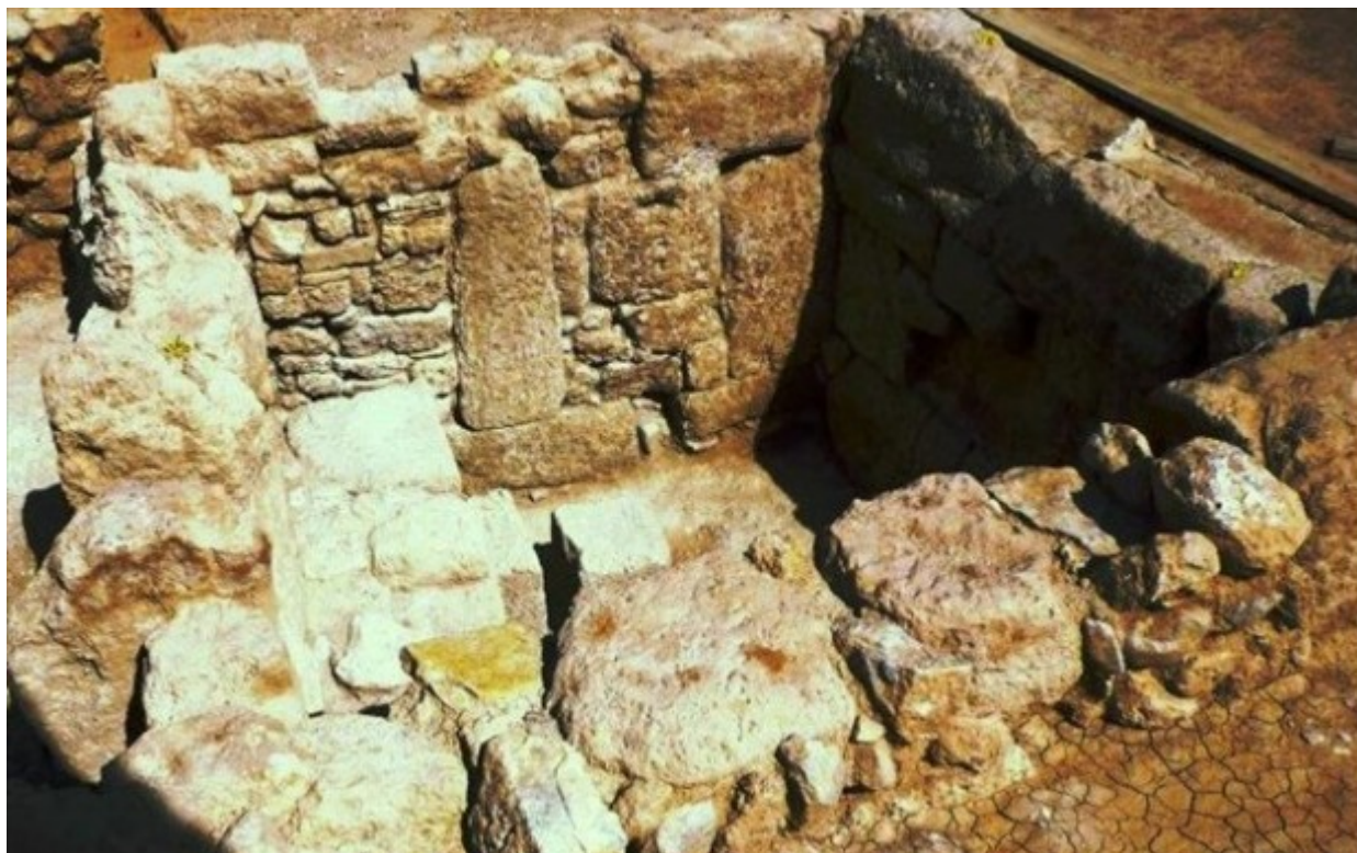
Μεγαρικά υπόγεια ήταν κατασκευασμένα από μεγάλα κομμάτια λαξευτών ογκολίθων που ανά τακτικά διαστήματα διακόπονταν από ένα κάθετο ογκόλιθο, σημείο που τα έκανε πολύ ισχυρά.
