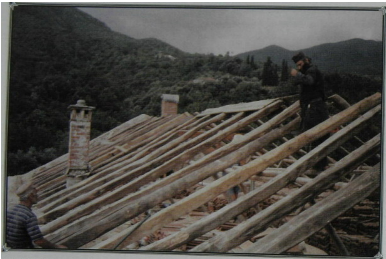
Ἀπό τίς ἐργασίες ἀποκατάστασεως τῆς στέγης τμήματος τοῦ Κελλιοῦ. Ὁ μοναχός Θεόκτητος, ἀδελφός κατὰ σάρκα τοῦ π. Εὐθυμίου καί ὁ μακαριστός πατέρας τους ἐπὶ τό ἔργον.
