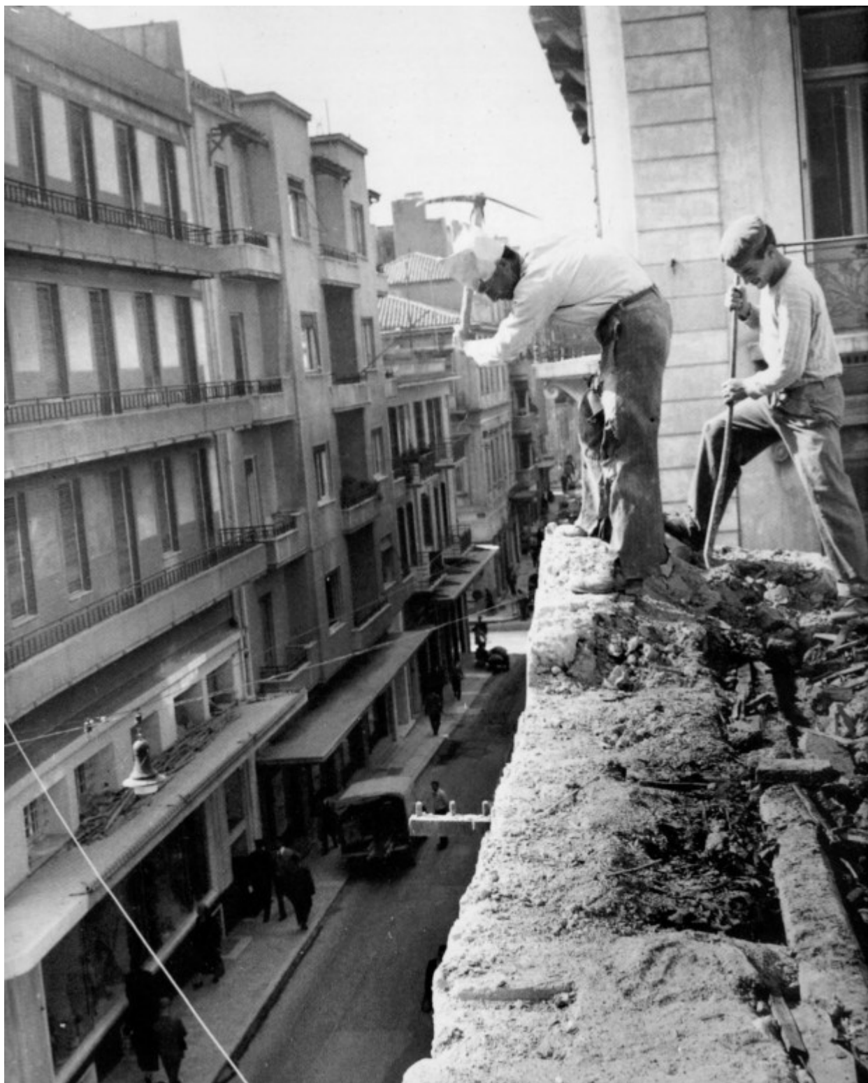
Εργάτες ακροβάτες! Γκρέμισμα κτηρίου μ' έναν κασμά κι έναν λοστό! Σάρωναν τα εργατικά ατυχήματα.
