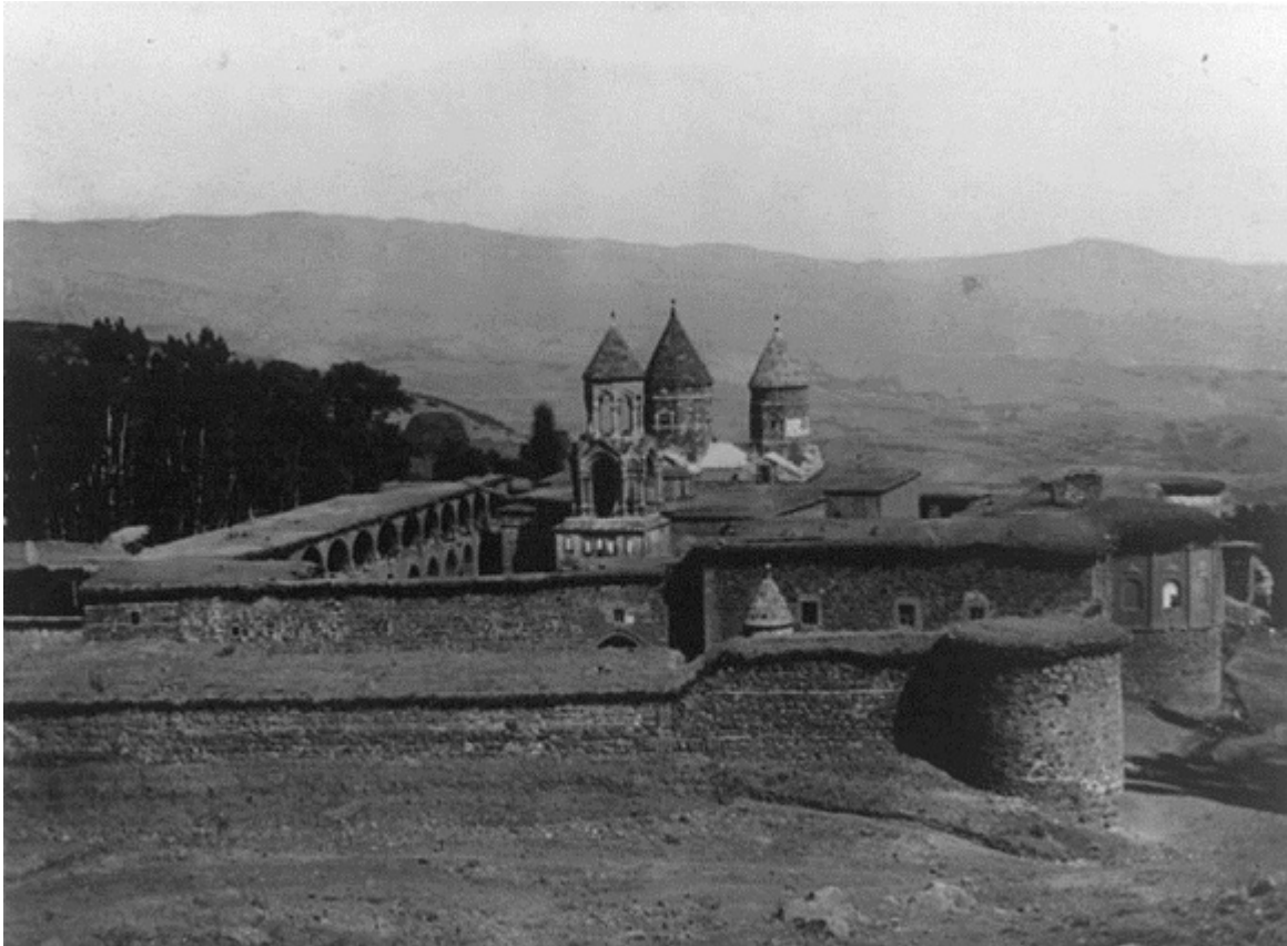
Φωτογραφία της Μονής του Αγίου Ιωάννου του Βαπτιστού(Saint Carapet Monastery), η οποία ελήφθη μεταξύ των ετών 1915-1923
