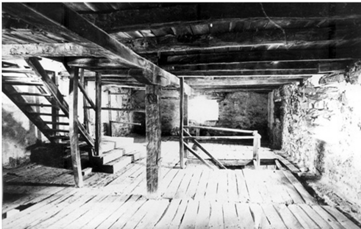
Το εσωτερικό του πύργου πριν την αποκατάσταση
