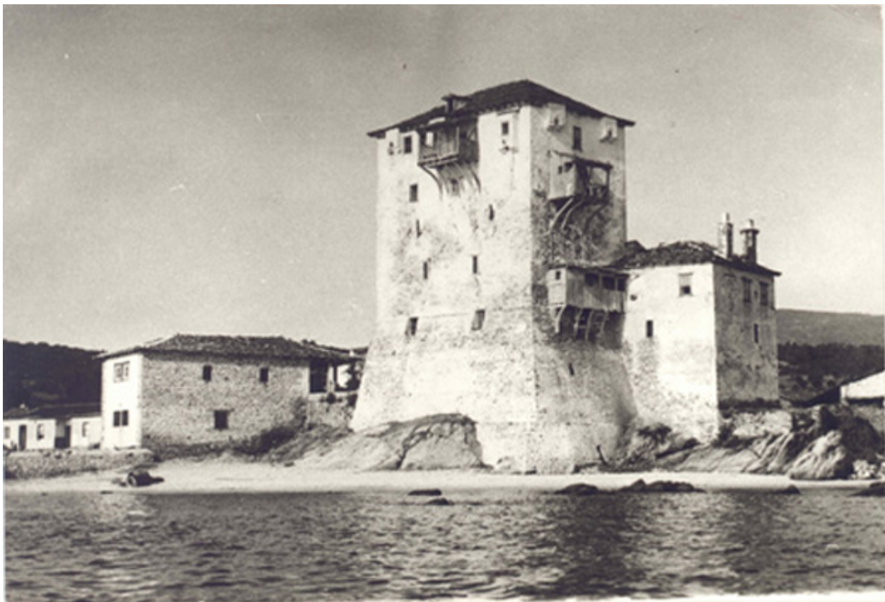
Ο πύργος πριν την αποκατάσταση πηγή: http://www.10eba.gr
