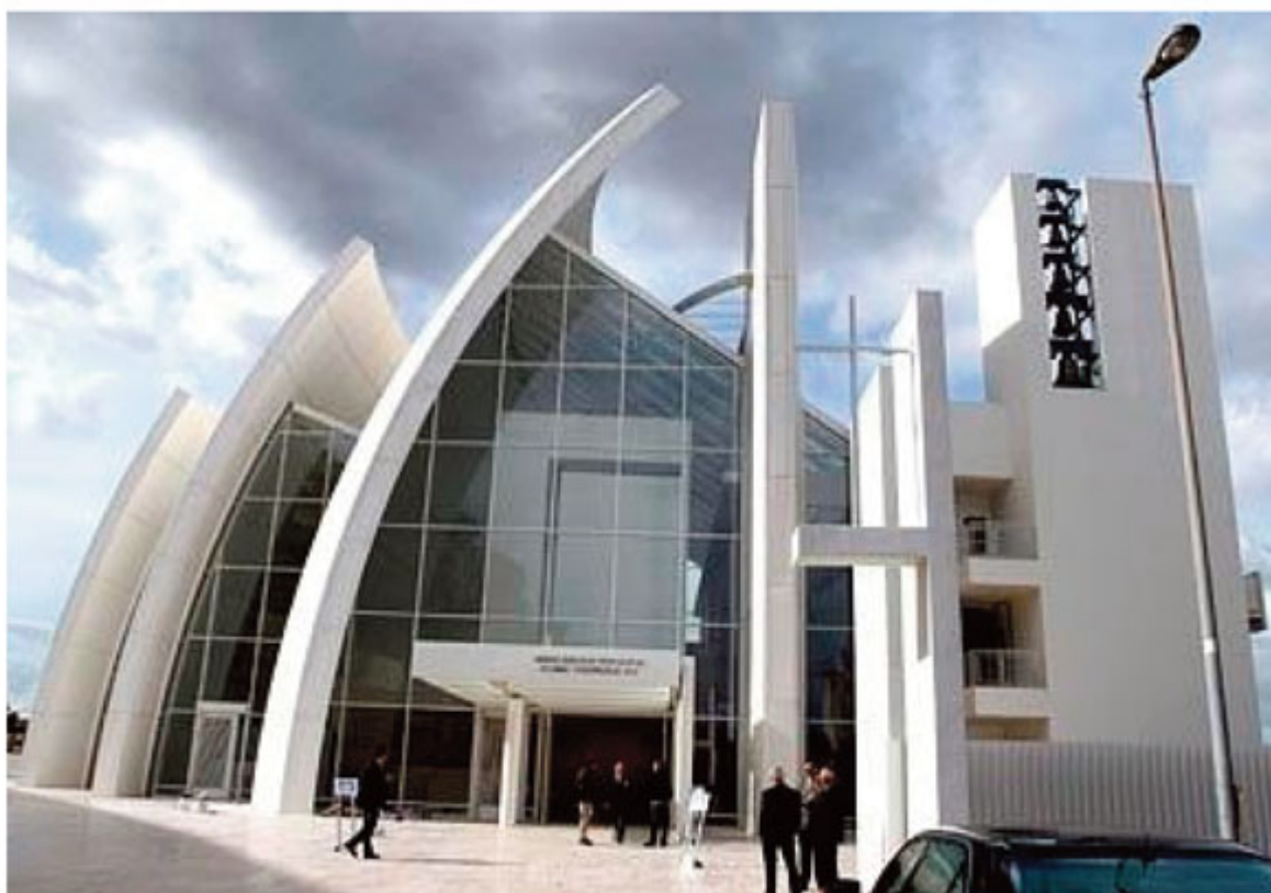
Η εκκλησία του Ιωβηλαίου στη Ρώμη (Ιταλία) στην οποία έχει χρησιμοποιηθεί αυτοκαθαριζόμενο σκυρόδεμα το οποίο επιτρέπει να διατηρείται η επιφάνεια λευκή (πηγή http://www.sltrib.com/business/ci_2883707 )
