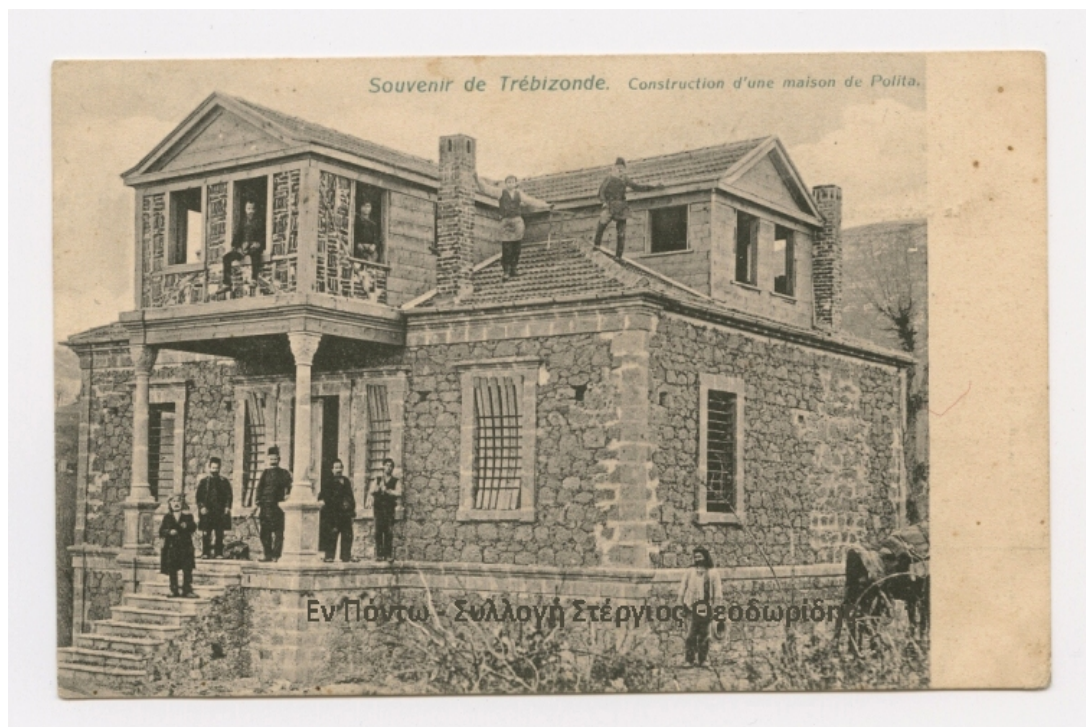
Κατασκευή κατοικίας στο χωρίο Πολίτα, κοντά στην Τραπεζούντα, © Συλλογή Στέργιος Θεοδωρίδης
