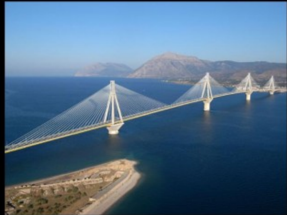
Γέφυρα Ρίου – Αντιρρίου [Χαρίλαος Τρικούπης]
