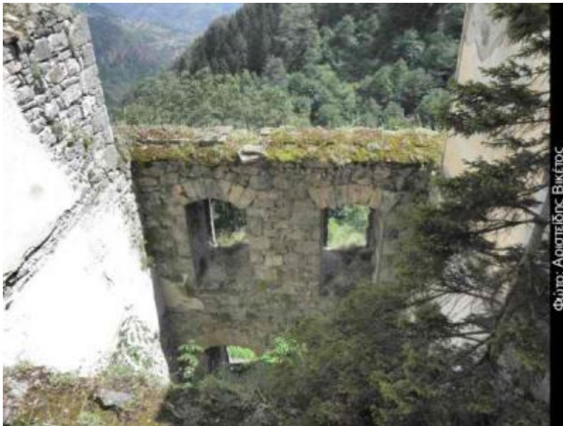
Από το εσωτερικό του μοναστηριακού συγκροτήματος
