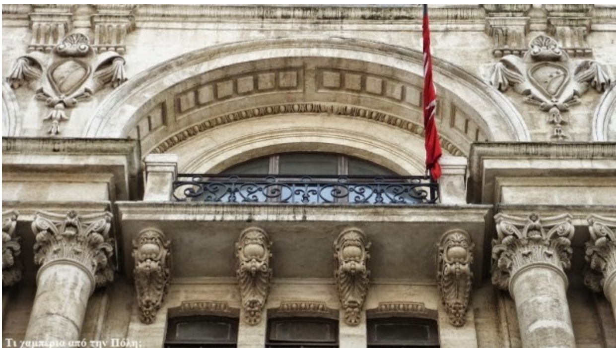
Διάκοσμος τράπεζας με κορινθιακούς κίονες, πανέμορφους γείσους και ανάγλυφες κορνίζες.
