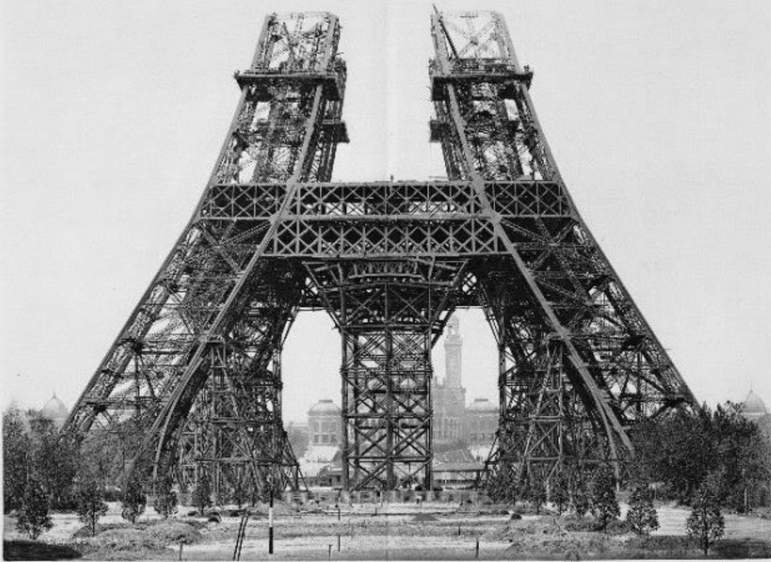
Montage des poutres en fer de 40 mètres - 12, Rue de la
