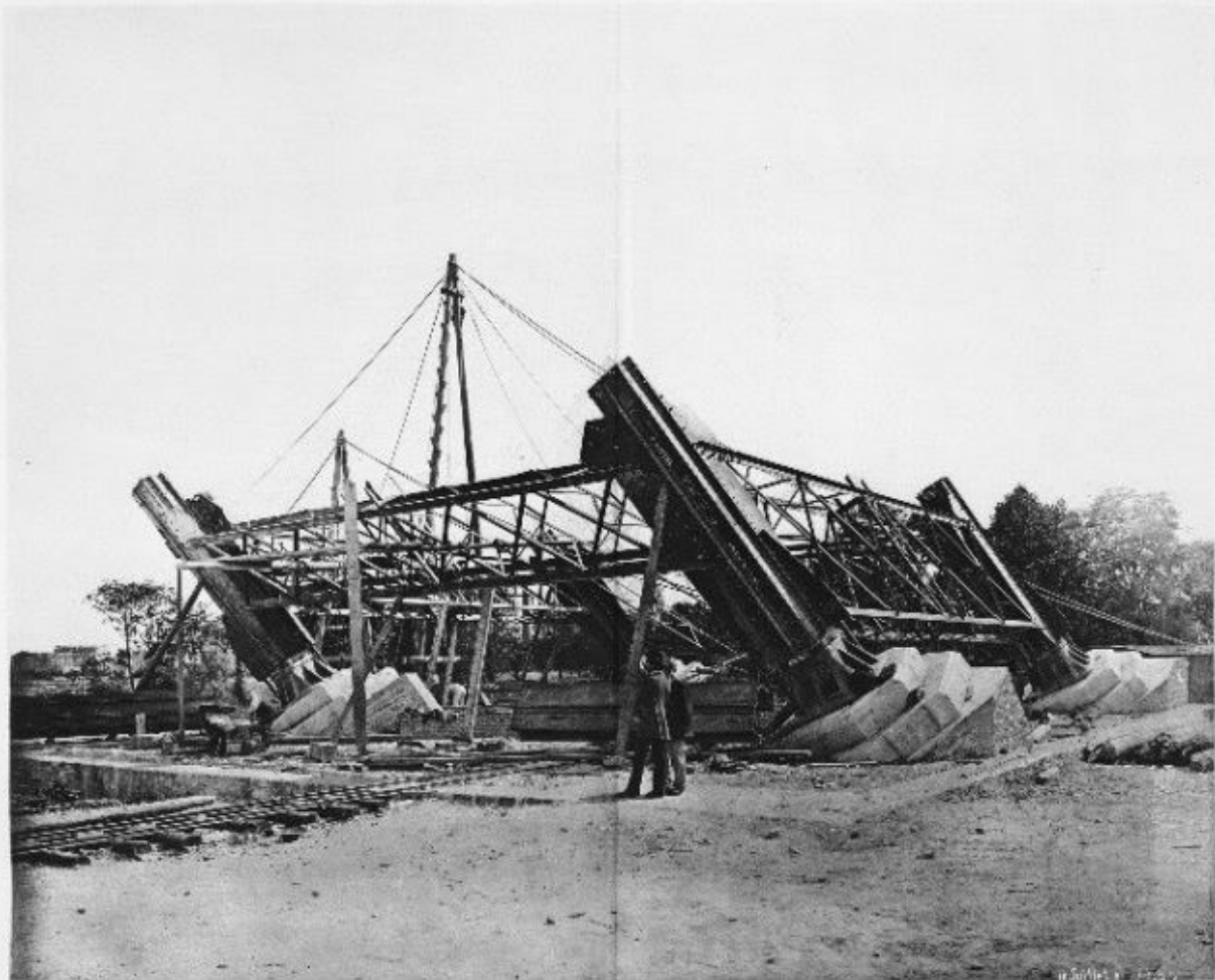
Commencement du montage métallique de la pile 2 e , à l'aval de la pile 1 re .
