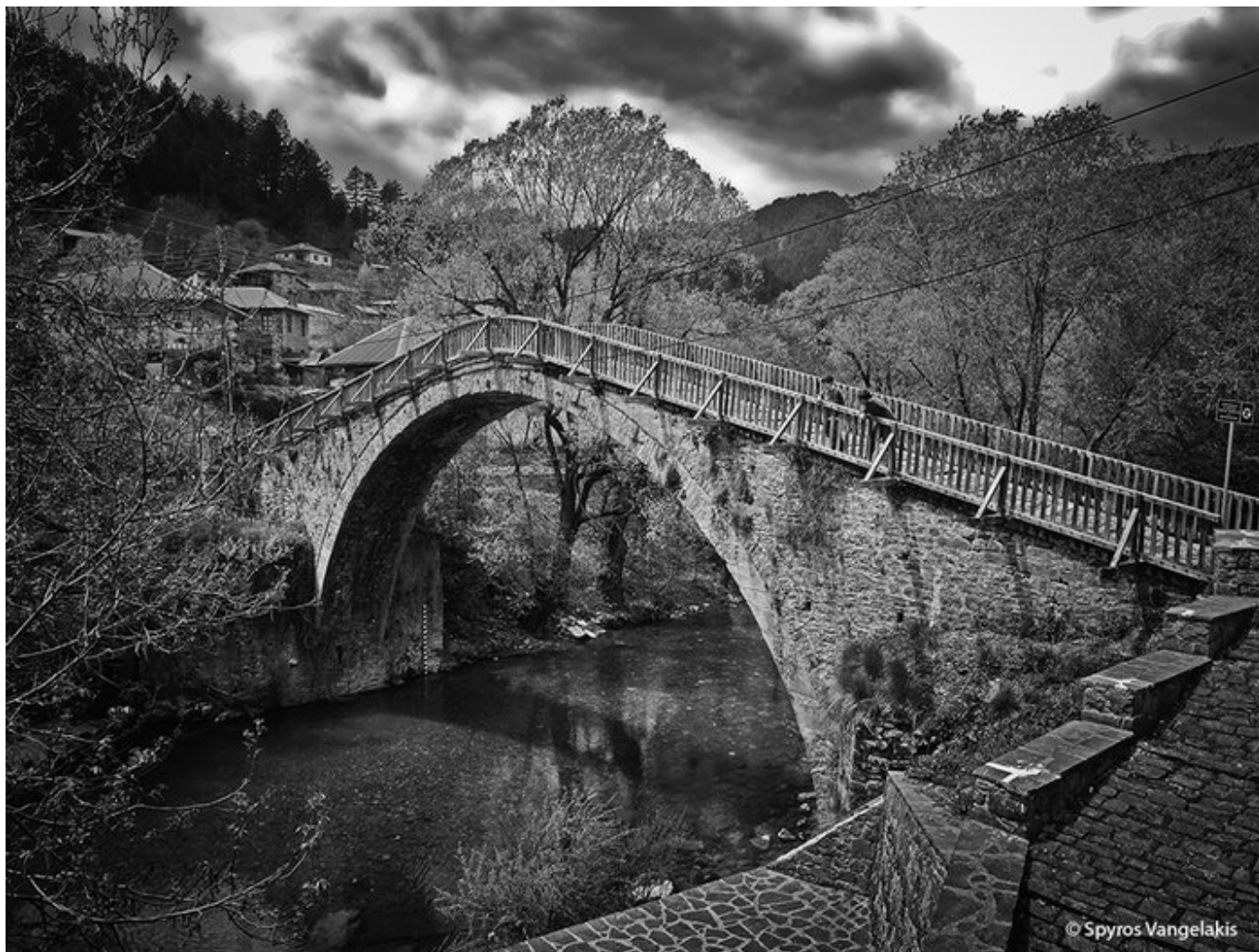
Γεφύρι της Βωβούσας (1748-Μονότοξο) : Βρίσκεται στο κέντρο του χωριού Βωβούσα στην περιοχή του Ανατολικού Ζαγορίου. Κτίστηκε το 1748, στις πηγές του Αώου, από τον Αλέξη Μίσιο. Το γεφύρι Πλακίδα- Καλογερικό
