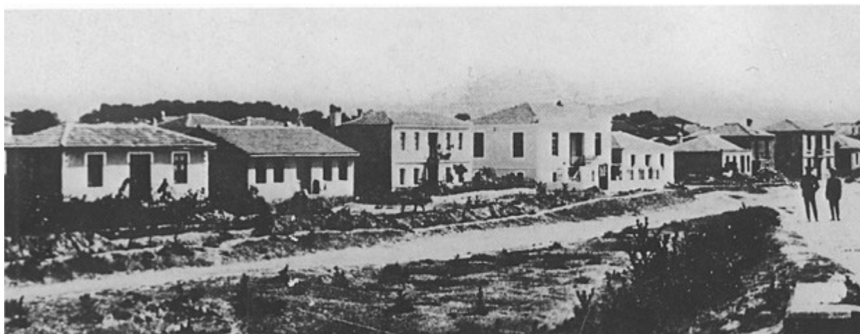
Προσφυγικές εγκαταστάσεις στο Λαγκαδά Θεσσαλονίκης.
