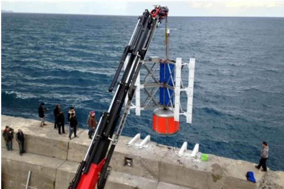
Το σύστημα περιλαμβάνει έναν πλωτήρα που ανεβοκατεβαίνει στα κύματα και κινεί ένα πιστόνι (Πηγή: SINN Power)
