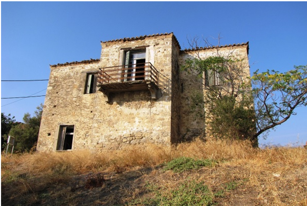
Εικόνα 1: Η βορειοανατολική πλευρά της πέτρινης έπαυλης του Οθωμανικού δυναστικού οίκου των Απδίμ - Παγιάνων την Συκιά Ξυλοκάστρου. Διακρίνεται η ορθογώνια πυργοειδής διαμόρφωση στην κατασκευή της.
