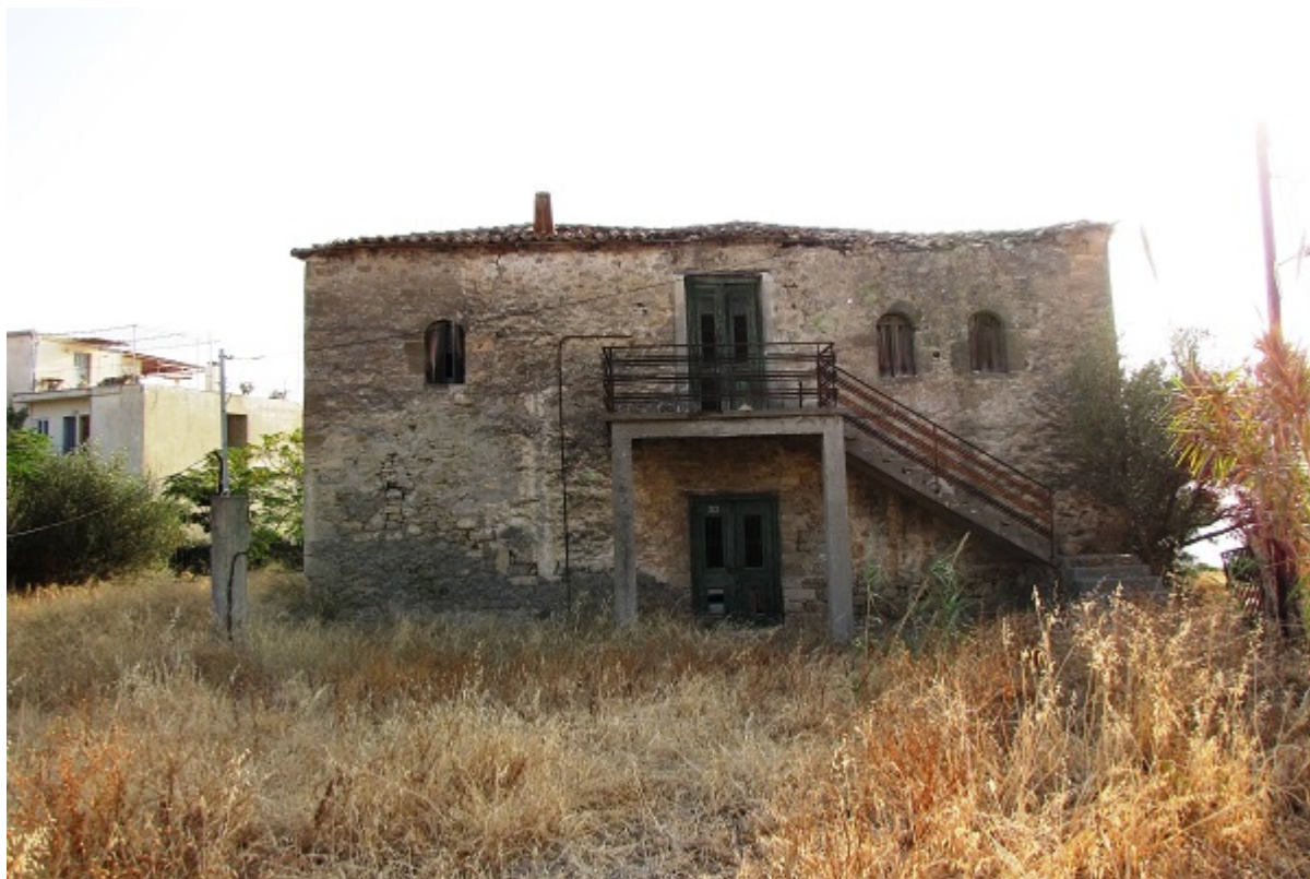
Εικόνα 3: Η νοτιοδυτική πλευρά του Οθωμανικού πυργόσπιτου της Συκιάς, που σύμφωνα με τις αποχρώσεις ενδείξεις, η θεμελίωση ενδέχεται να έγινε στις αρχές του 18ου αιώνα από τον Χαλήλ Μπέη. Τοτσιμεντένιο κλιμακοστάσιο προς τον δεύτερο όροφο είναι προφανώς προσθήκη της σύγχρονης εποχής.
