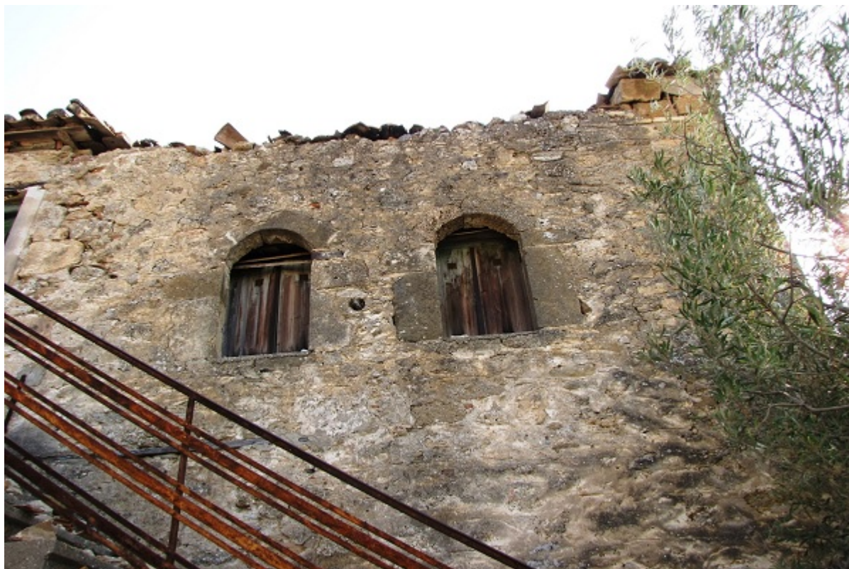
Εικόνα 6: Άποψη των δύο εκ των τριών τοξωτών παραθύρων του δεύτερου ορόφου της νοτιοδυτικής πλευράς (πρόσοψη). Εκτιμάται ότι ανήκουν στην αρχική κατασκευή του πυργόσπιτου.
