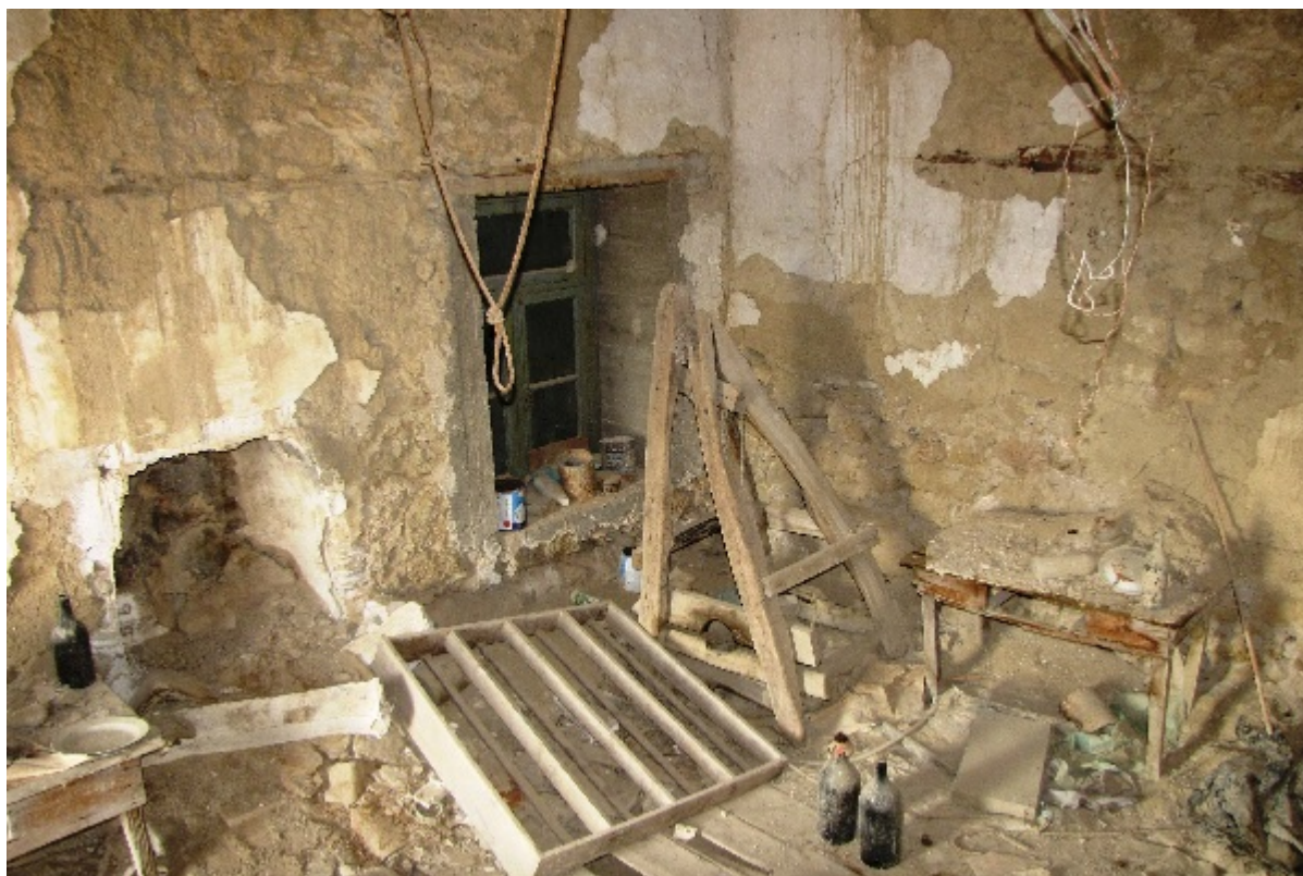
Εικόνα 9: Άποψη του εσωτερικού του νοτιοανατολικού θαλάμου του ισόγειου ορόφου, όπου υπάρχουν παλαιά έπιπλα σε κακή κατάσταση και διάσπαρτα απορρίμματα. Στα αριστερά του παραθύρου διακρίνεται το τετράγωνο άνοιγμα από το τζάκι.
