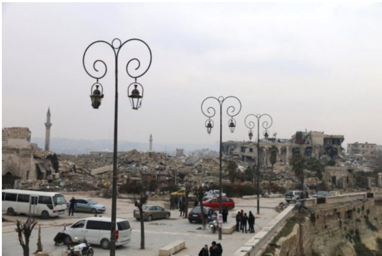
Τα συντρίμια του ξενοδοχείου Carlton και άλλων κτιρίων στη γύρω περιοχή, Ιανουάριος 2017. © UNESCO
