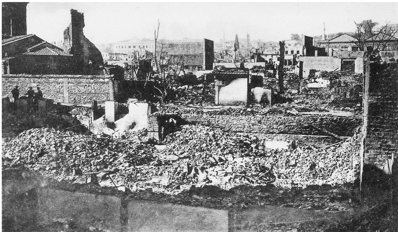
72. - SALONIQUE 1917. - Les plus beaux immeubles n'ont pas été épargnés
