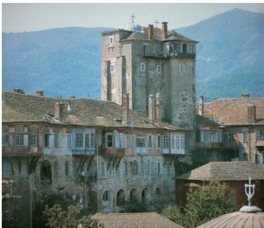
Ιερά Μονή Βατοπαιδίου, πύργος της Μεταμορφώσεως.
