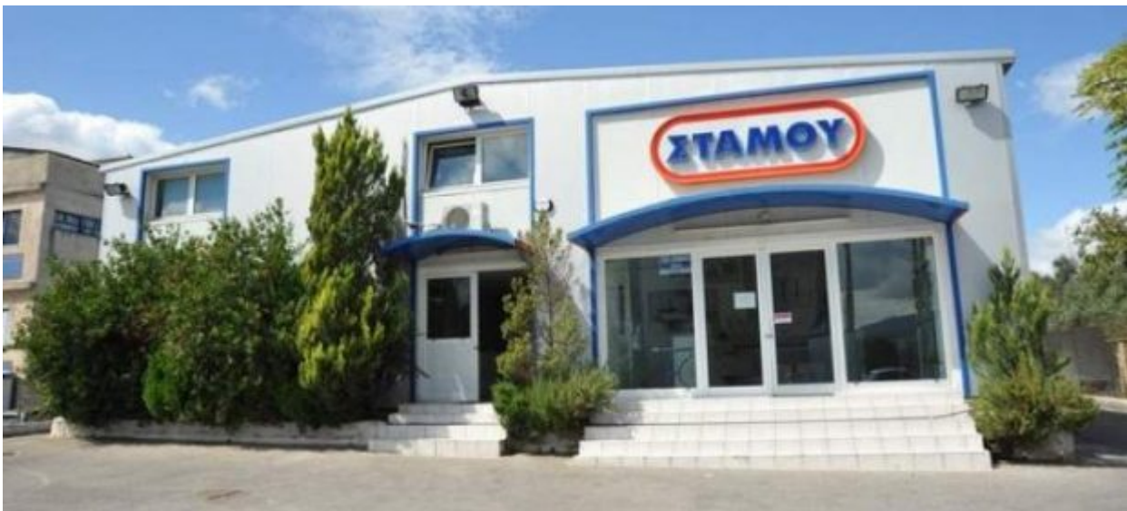
Από τις εγκαταστάσεις της γαλακτοβιομηχανίας Στάμου
