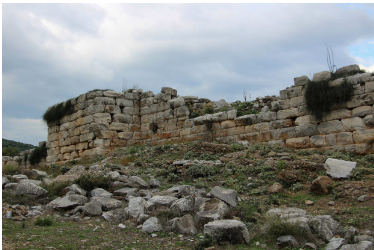
Τμήμα του Νότιου τείχους, κτισμένο με προσεκτικά δουλεμένες πέτρες από το γειτονικό λατομείο.
